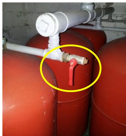
Figures 7 : Vanne d'isolement non déposée
