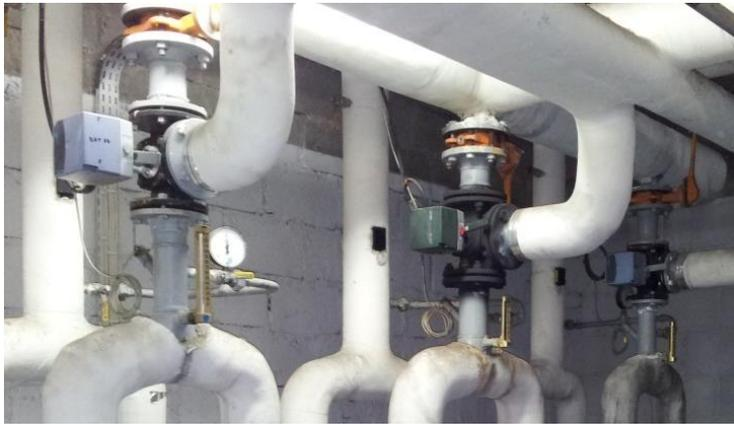
Figure 9 : Vannes 3 voies départ bâtiments A-B, C-D, E
