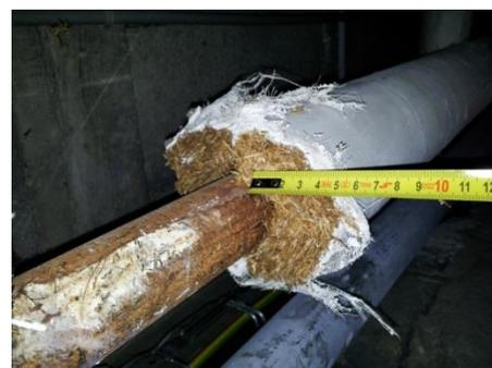
Figure 11 : Calorifugeage réseau en chaufferie et cave
