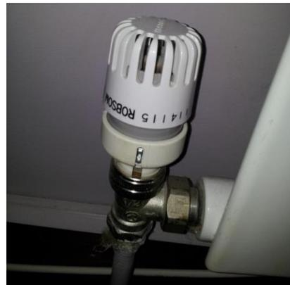
**Figure 15 : Radiateur acier et robinet thermostatique**
