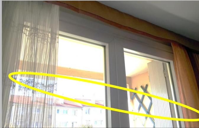
L'absence d'entrée d'air ou des grilles d'aération obstruées peut causer un mauvais renouvellement d'air et donc l'apparition de condensation et de moisissure :
