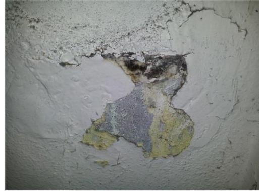
Figure 2 : Mur cellier : problème de moisissure et détérioration
