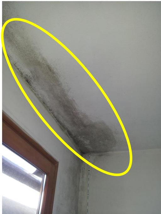
Figures 6: Problème d'étanchéité de la toiture ou de condensation
